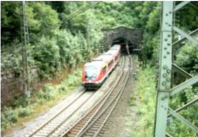
Schwarzkopftunnelportal Hain. Foto wikipedia .
